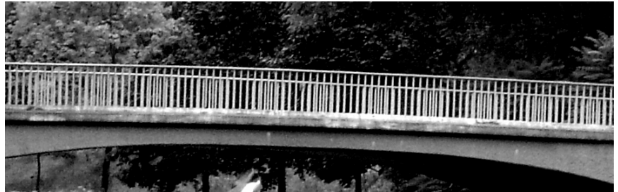
Abb. 10: Brückengeländer mit Moiré-Effekt (aus [Selzer 2006])
